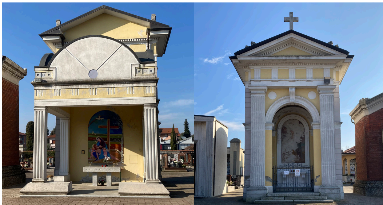
Figura 32. Individuazione della Cappella storica e dell'ossario comune situato al di sotto del medesimo edificio, Cimitero di Bernareggio, via A. Gramsci, 10
