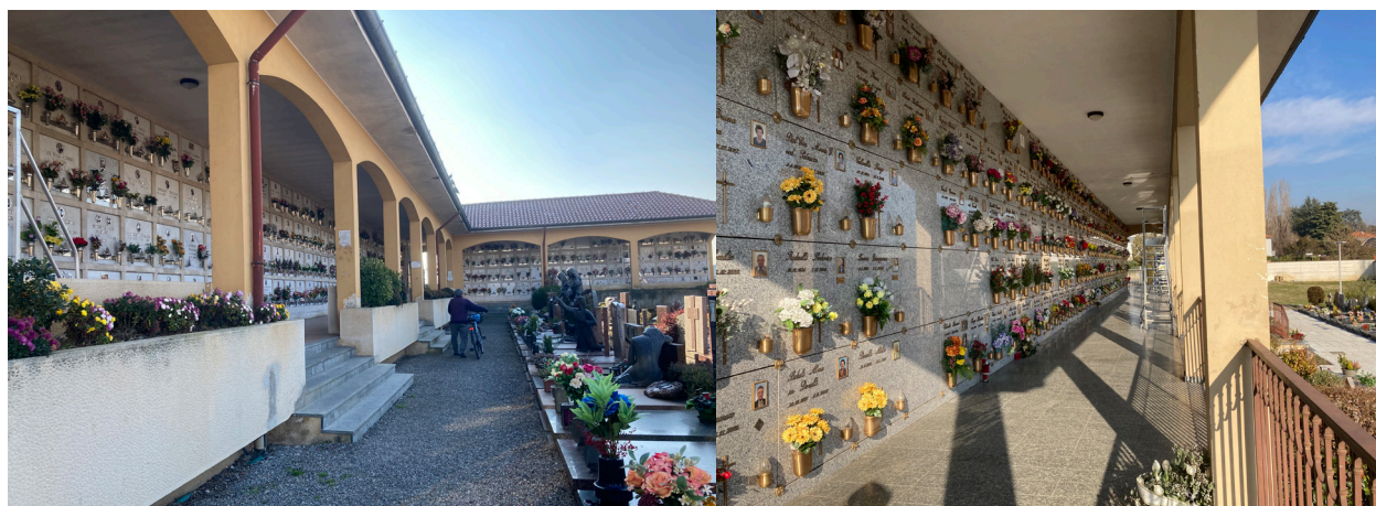
Figura 26. Colombari per loculi e/o ossari/cinerari [campo 'F', 'E', 'H'], Cimitero di Bernareggio, via A. Gramsci, 10
